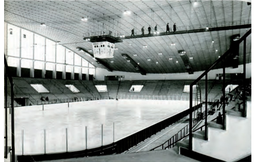
Hallin päätila lopputarkastuksen aikaan vuonna 1965. Tarkastajat kulkevat kellosillalla 18 metrin korkeudessa. Kuva: Hirvikallio, 2015; Leinonen, 2015
